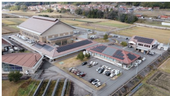
公共施設に導入された太陽光電池
