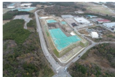
写真3-5-2 土壌貯蔵施設
