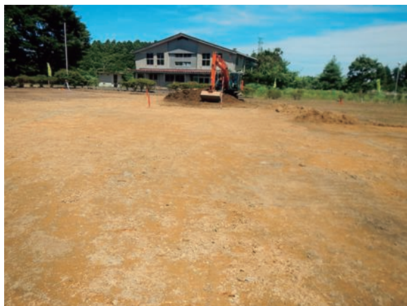
大熊町の大野幼稚園除染作業の様子
