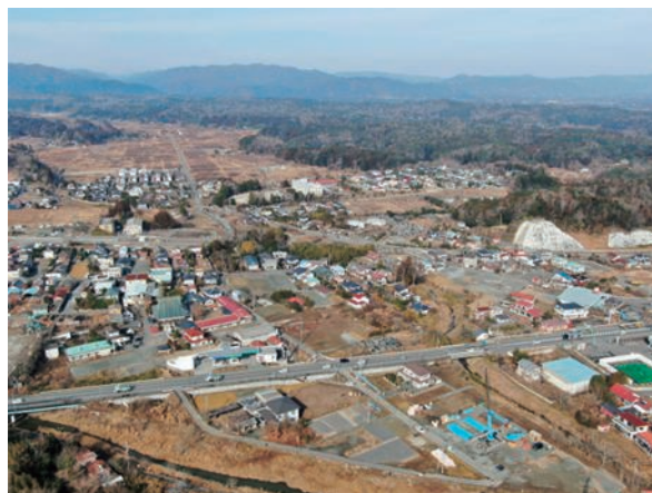
双葉町除染作業の様子（空撮）
