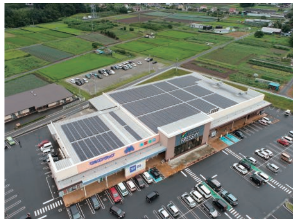
太陽光発電システムを設置した商業施設
