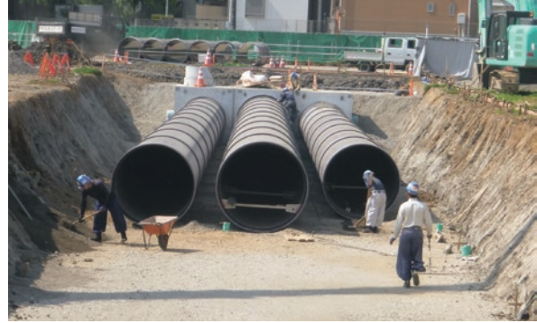
雨水貯留管「エスロンRCP」埋設風景
