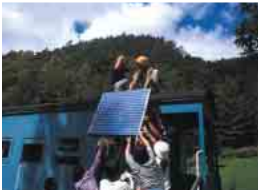
太陽光パネルの設置
