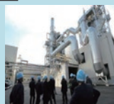
バイオマス発電所
