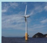
洋上風力発電施設
