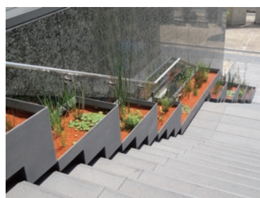
京都駅ビルの緑水歩廊
