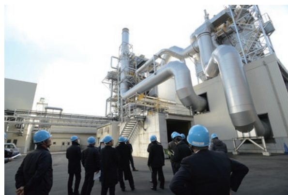
真庭バイオマス発電所
