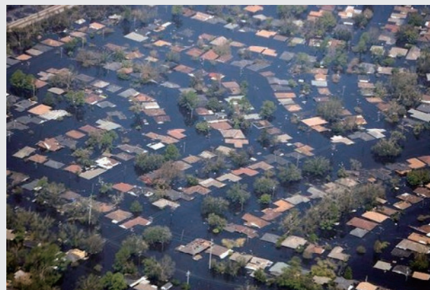
写真2-1-1 ハリケーン・カトリーナによる浸水被害
