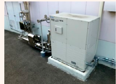
写真3-2-2 地中熱ヒートポンプ
