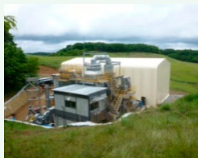
写真 2-2-8 鮫川村：農林業系副産物 等処理実証事業
