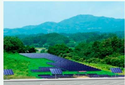
写真2-3-10 福島空港メガソーラー完成イメージ
