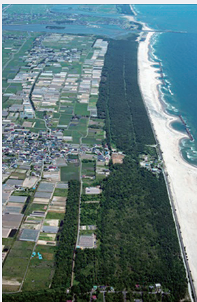
壊滅的な被害を受けた海岸防災林
