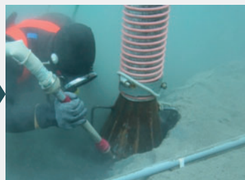
海底での泥土除去作業
