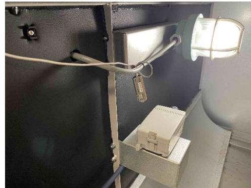
測定点 (熱交換予冷後)
