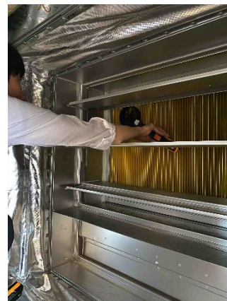
風量測定状況
