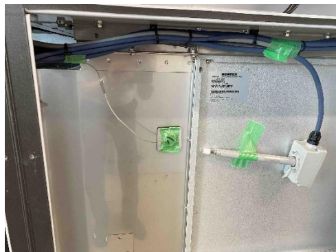
測定点 (コイル冷却後)
