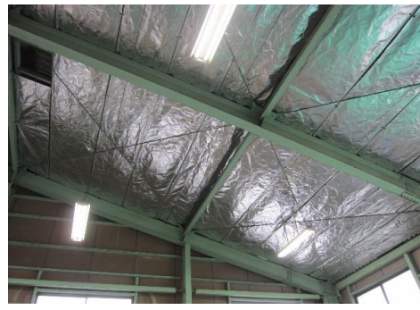
倉庫 A のキープサーモウォール断熱施工の状況
