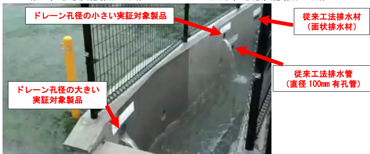
大雨時の排水状況
