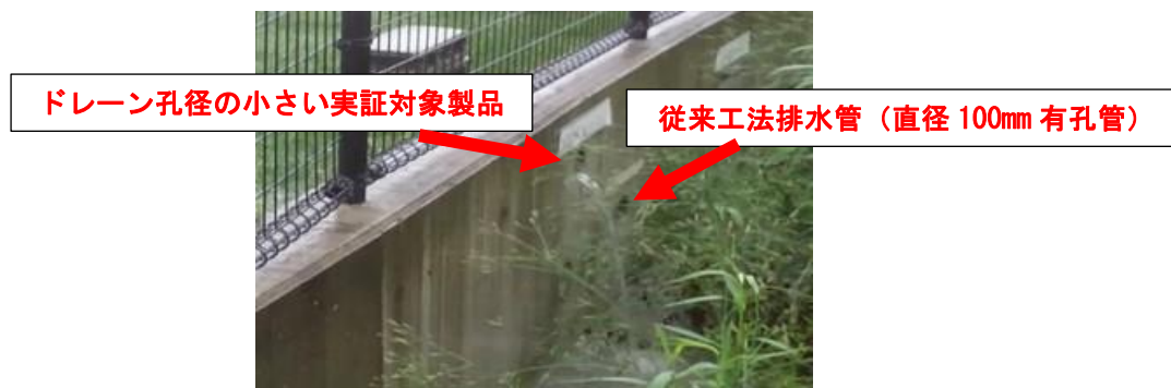
図4-4 施工から約4年経過後の大雨時の実証対象製品等の排水状況（外観） （ドレーン孔径の小さい実証対象製品と直径100mmの有孔管のみ。他の菅の外観なし）
