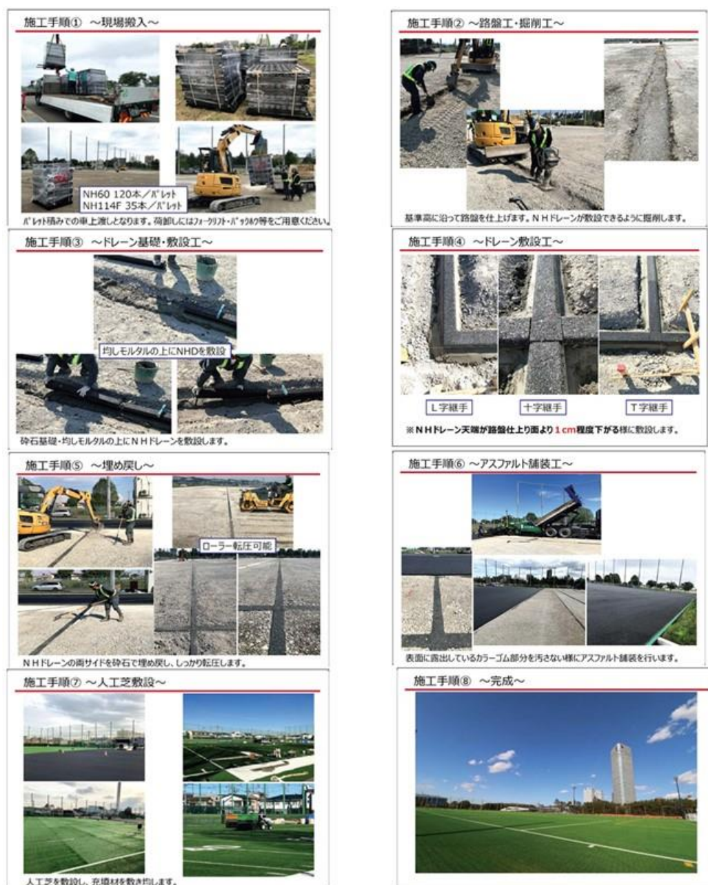
図3-4 実証対象製品の施工手順
