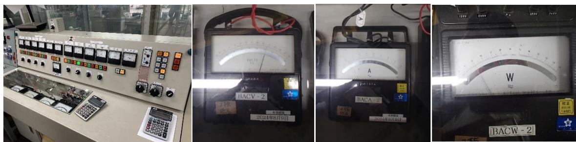
図 13 ブロワのモータに接続した電圧計、電流計、電力計
