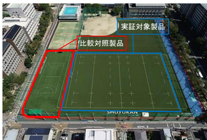
図5-2 試験実施場所の外観（フィールド試験）
