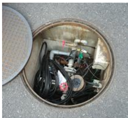
写真2 循環井Y-3の内部
