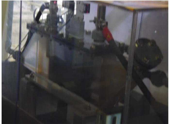
写真 2-5 次亜塩素酸ソーダ生成電解槽
