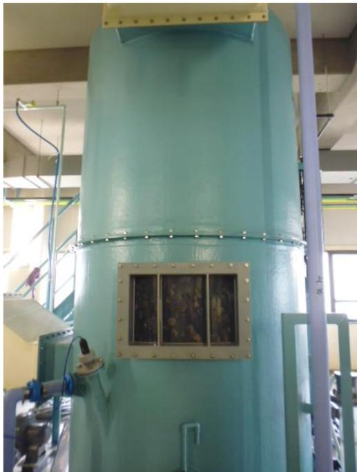
写真 2-1 湿式酸化触媒洗浄塔
