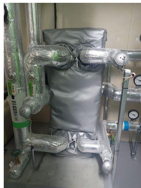
写真6 HEX-1 プレート式熱交換器
