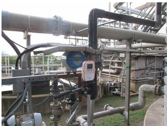
図 5-2 インターバルカメラによる流量メーターの監視風景
