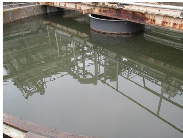
沈殿槽の状況
