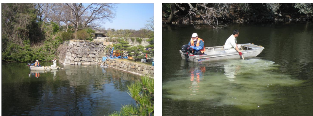
図 4-4 作業船を用いた散布状況
