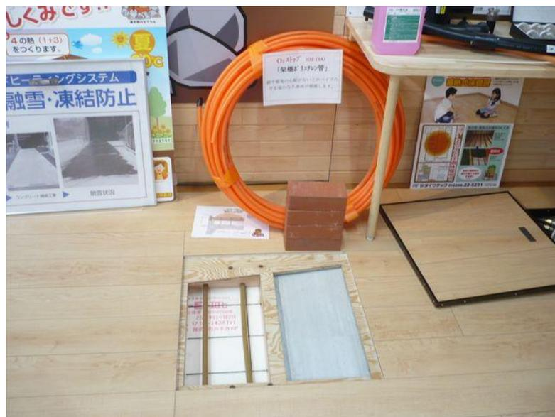
写真 3-4 床暖房のパイプ見本と床下の配管
