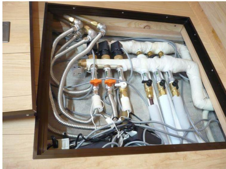
写真 3-5 室内機配管の分岐ヘッダー
