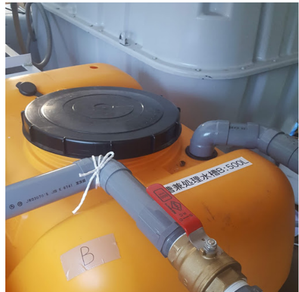
写真 16 混合槽兼処理水槽 B
