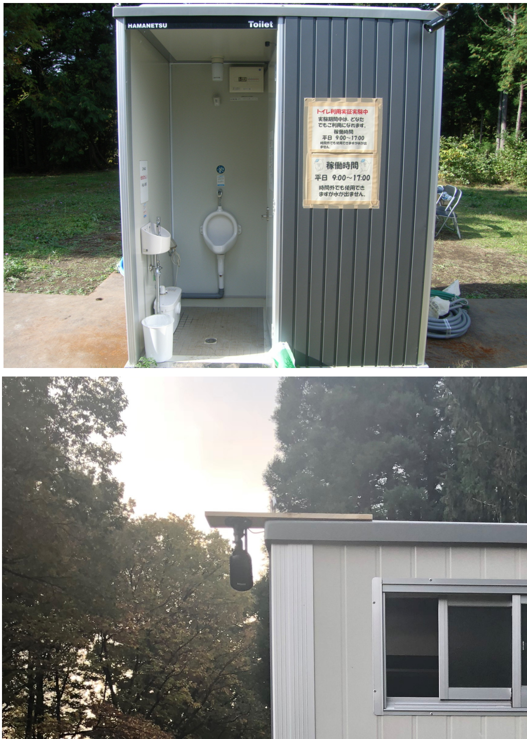
図 5-4-1-1 監視カメラの設置状況
