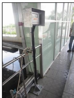
図 3-7 D 下水処理場における LD0 計の設置状況
