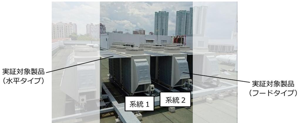
図 4-8 室外機及び実証対象製品の設置状況 (外観)
