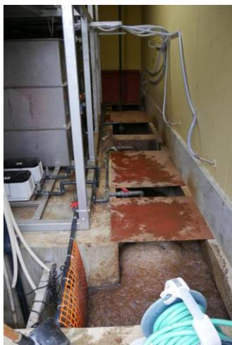
写真⑥微生物処理槽
