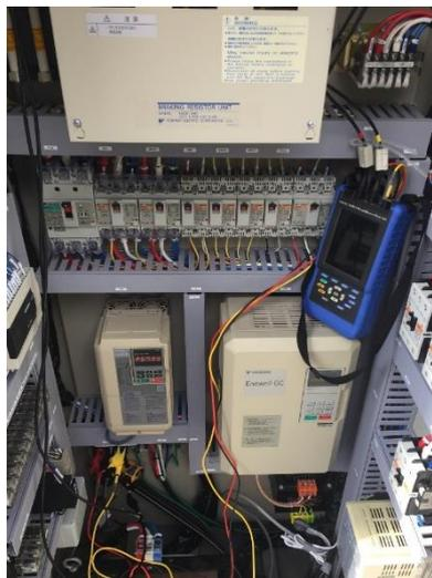
写真 4-1 電源品質アナライザの配線
