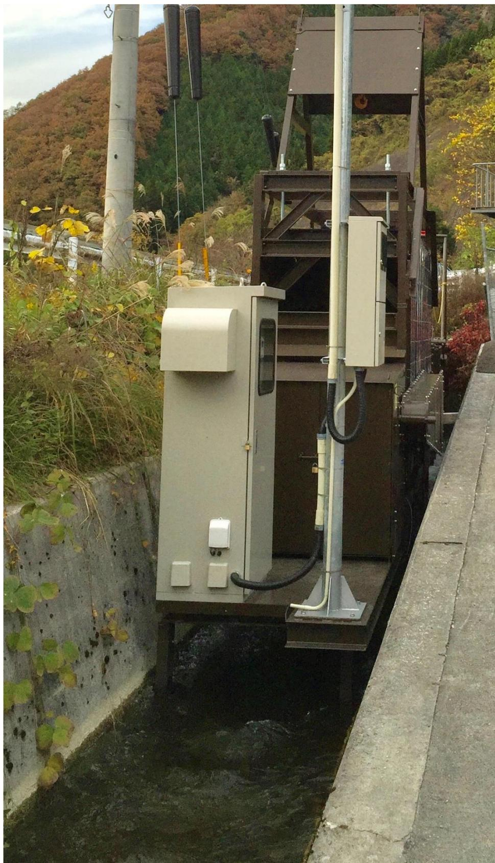
写真 8-1 下流から見た水車と電気設備
