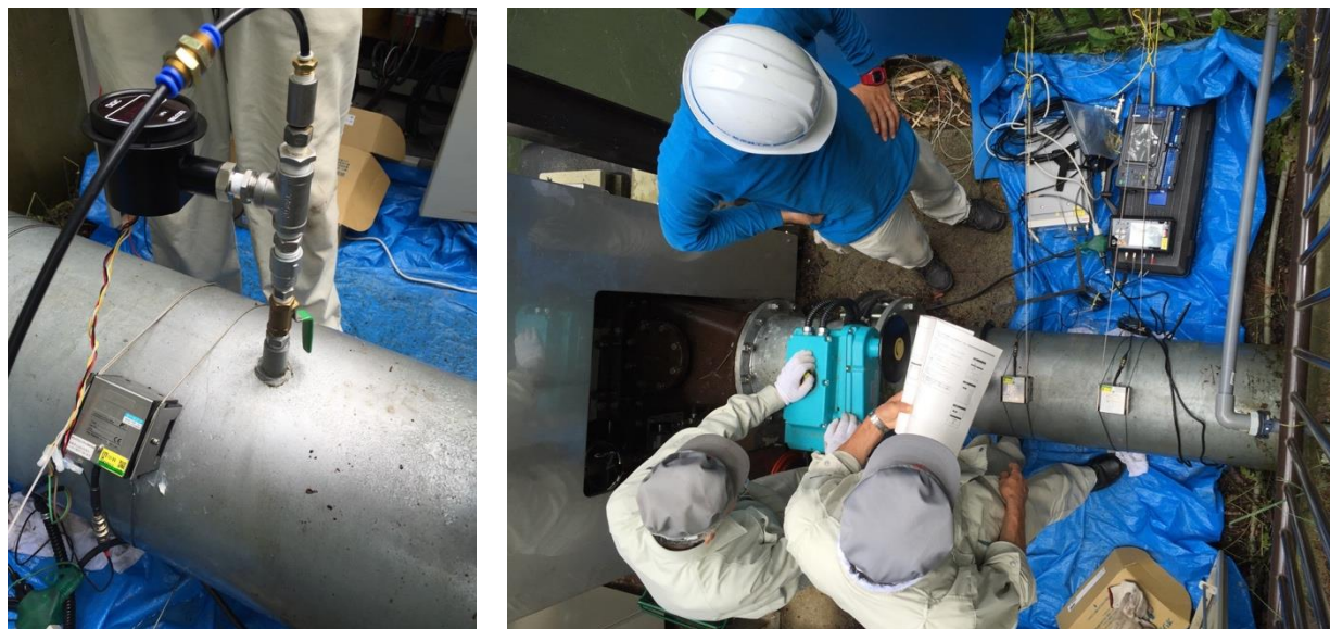
写真 4-1 流量計と圧力計の設置とロガーへの配線
