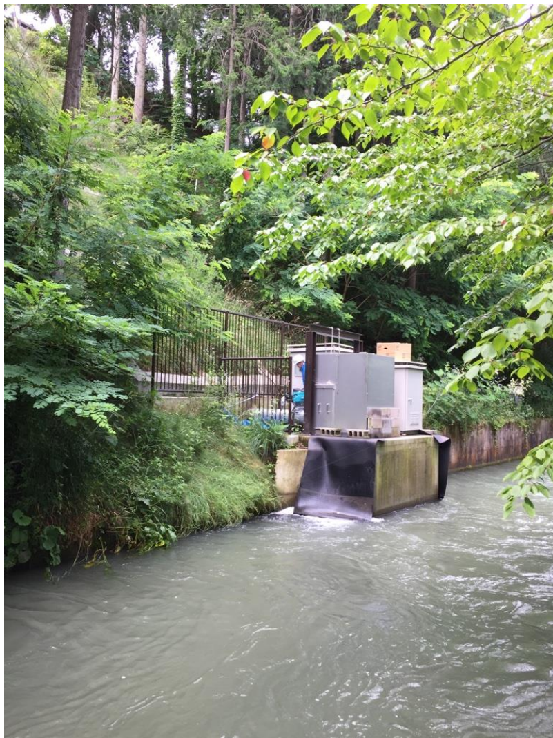
写真 5-1 発電設備の概観
