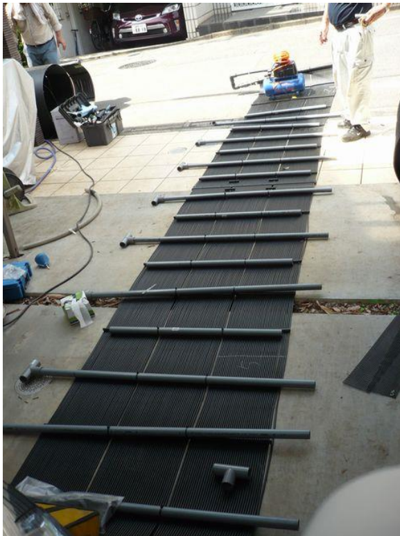
写真 3-3 シート状地中熱交換器 (G-カーペット) を展開した状態
