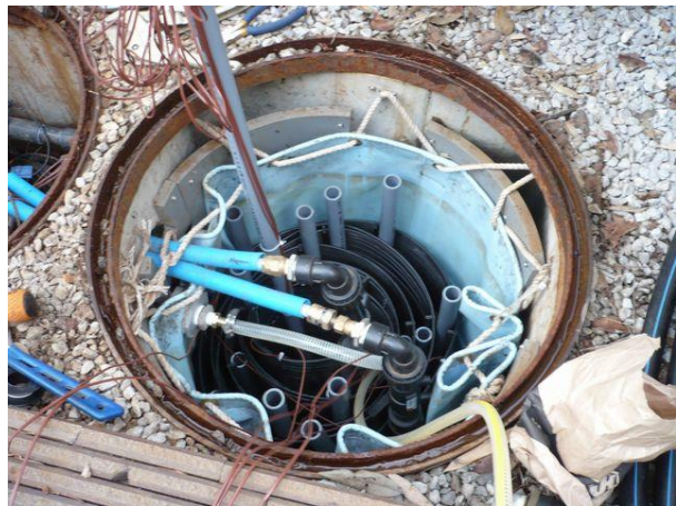
写真 3-6 タンクに巻き込んだシート状地中熱 交換器を入れて、配管を接続した状態
