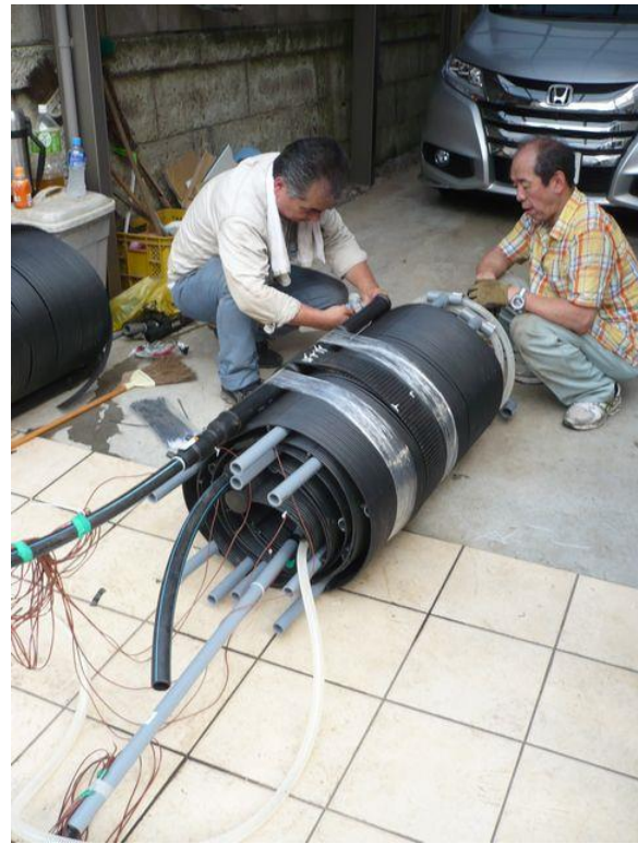
写真 3-4 シート状地中熱交換器 (G-カーペット) を巻き込んだ状態
