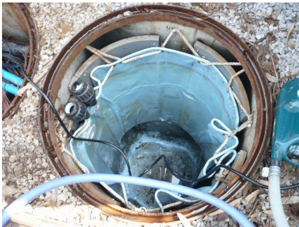
写真 3-5 タンクにシート状地中熱交換器 を入れる前の状況
