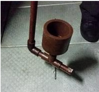
会所マスに設置した ポンプのノズル
