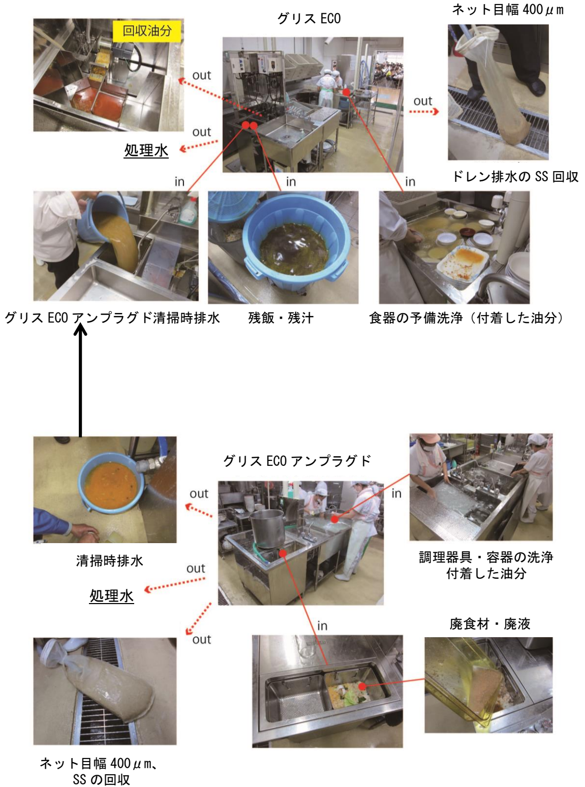
図 油分回収部の作業フロー
