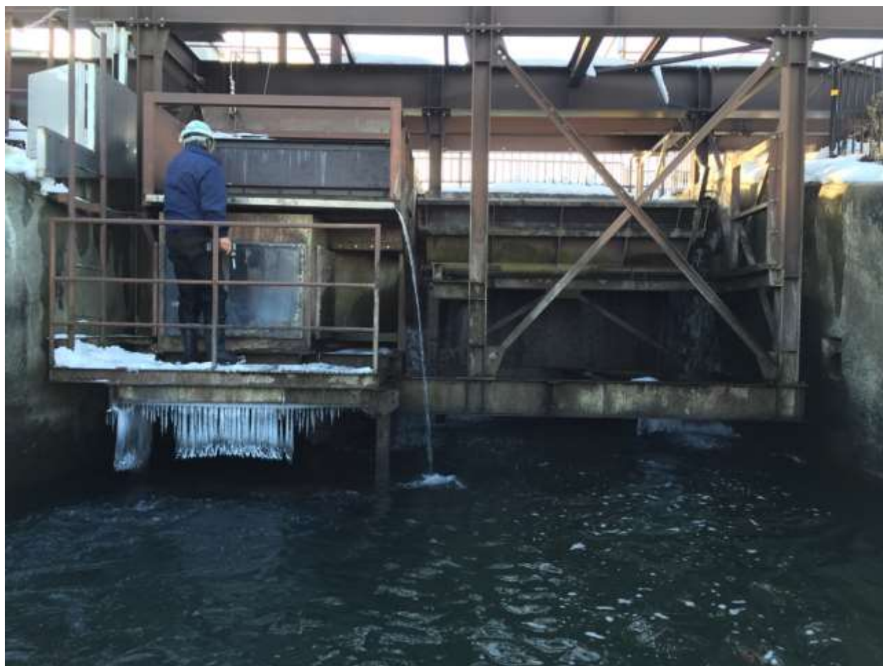
写真 3-1 設備外観（下流から見た発電設備）
