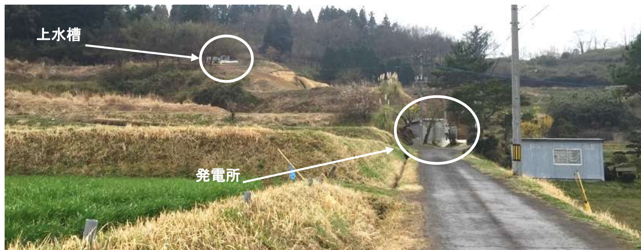
写真 6-1 発電設備の概観
