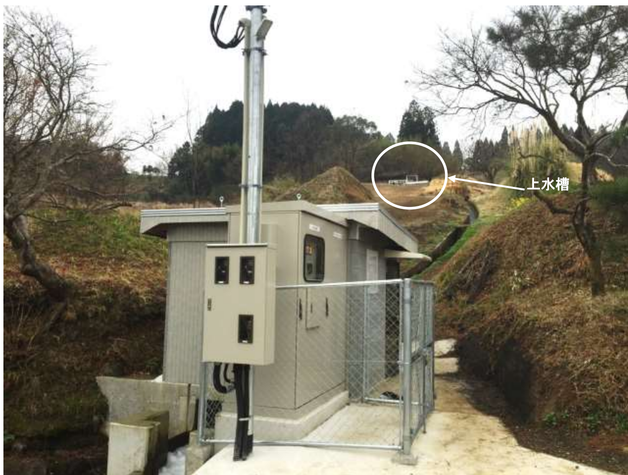
写真 6-2 発電所から上水槽を見上げる
