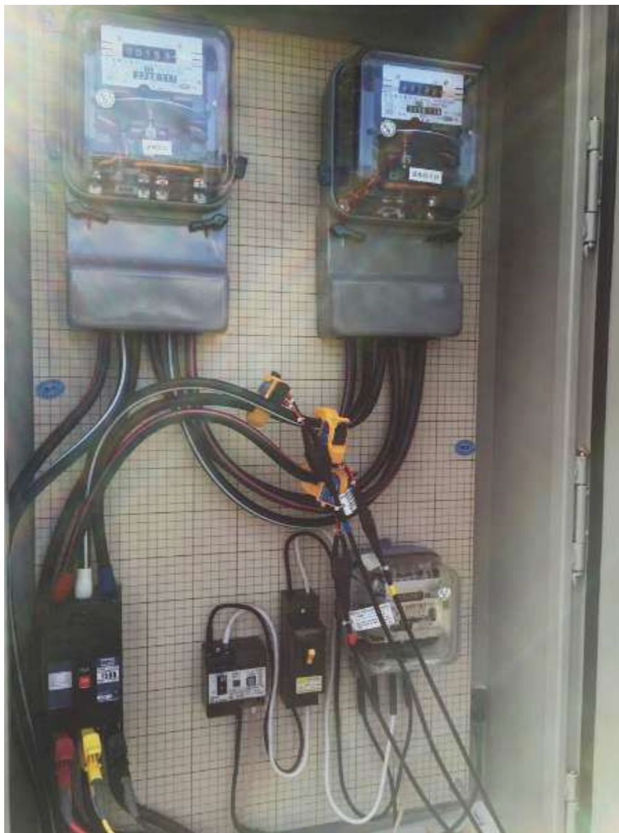
写真 8-2 電源品質アナライザの配線
