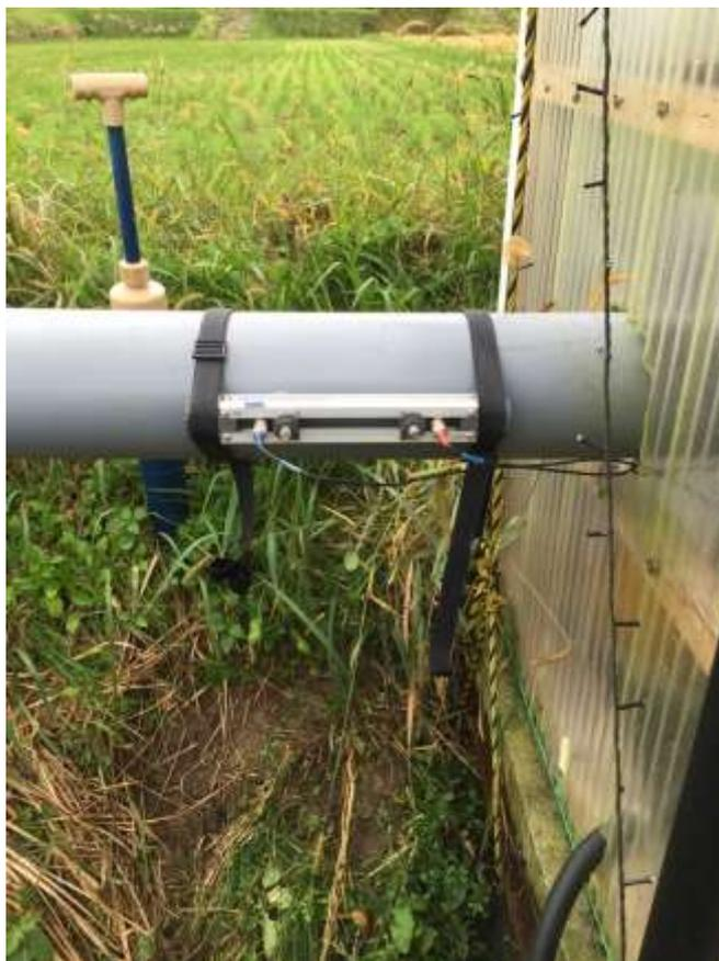
写真 8-1 超音波流量計の設置
