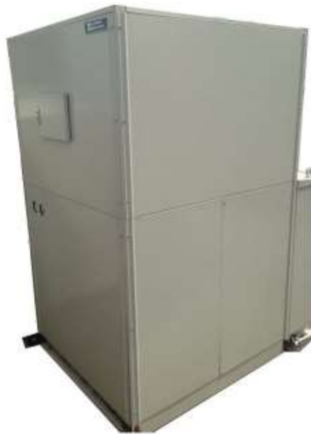
写真 3-1 実証対象技術(高効率大容量ヒートポンプチラーZQHt-45W45st)の写真
