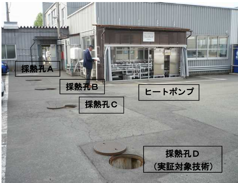
写真1 実証対象技術の全景 奥の建物が冷暖房の事務所
