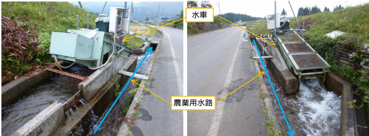
写真 3-1 上流側からの水車設置状況
