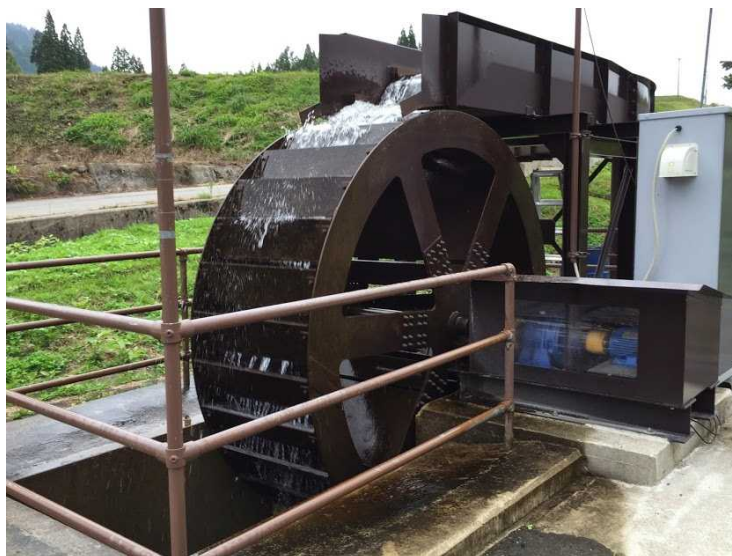
写真 3-1 水車の設置状況
