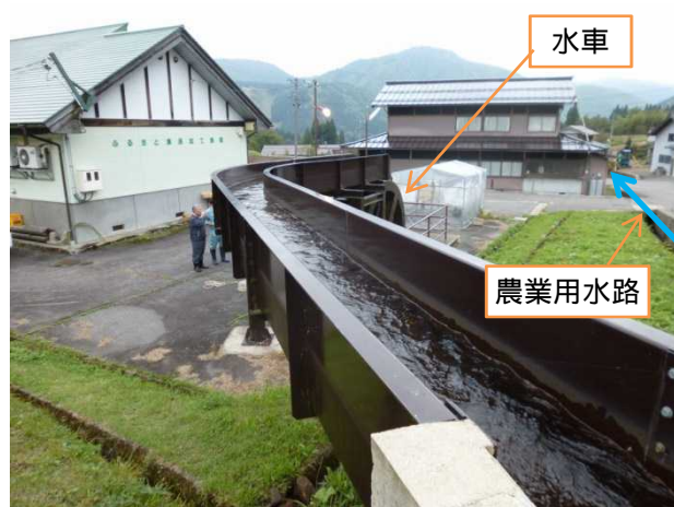
写真 3-3 水車導水路と水車
