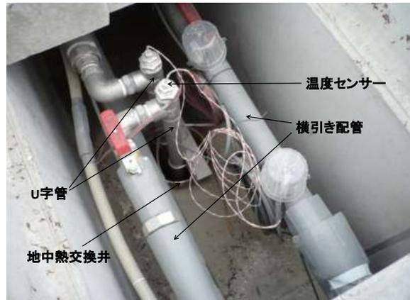
写真3 地中熱交換井の口元
