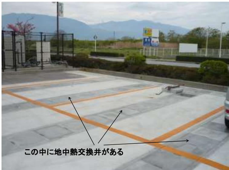
写真 3-2 地中熱交換井の設置エリア
