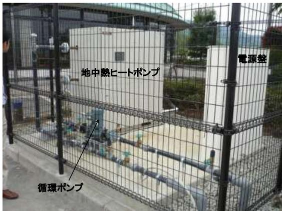
写真2 地中熱ヒートポンプと循環ポンプ
