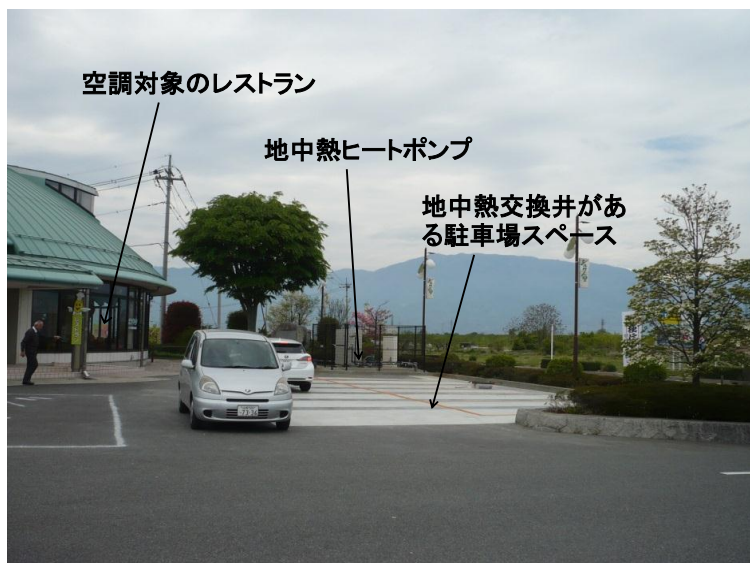
写真1 実証対象技術の全景
