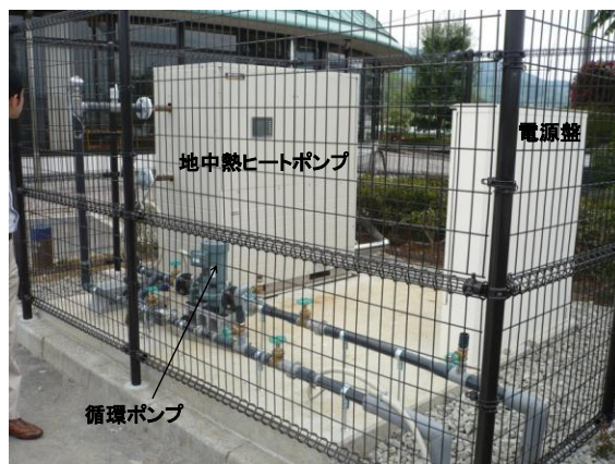
写真2 地中熱ヒートポンプと循環ポンプ
