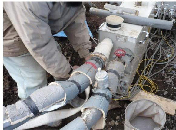
写真4 配管に保温材を巻く作業
