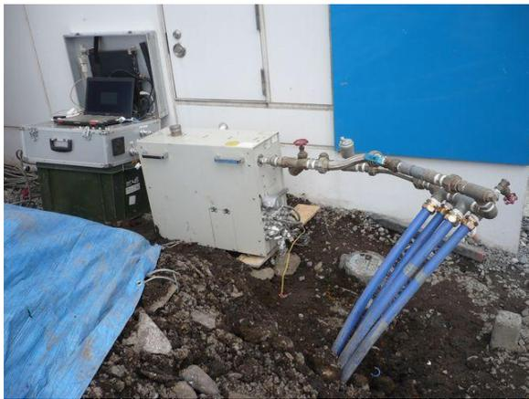
写真3 加熱循環配管の状況
