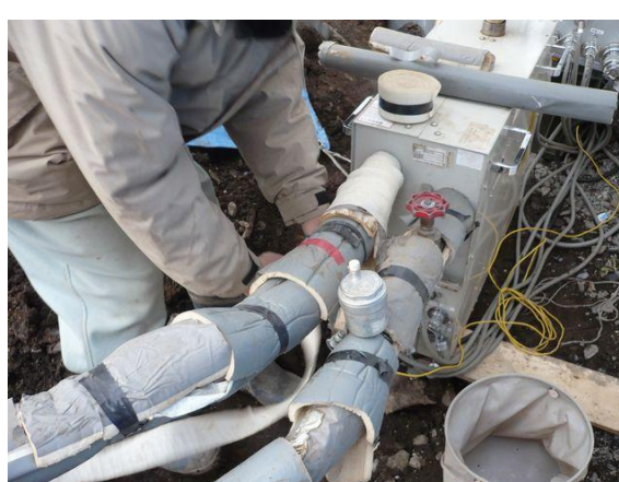
写真4 配管に保温材を巻く作業
