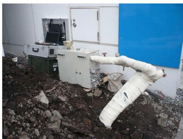
写真5 保温材を巻終った状況
