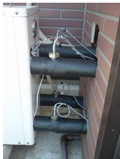
写真5 ヒートポンプ入口出口温度計
