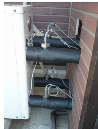
写真4 ヒートポンプ入口出口温度計
