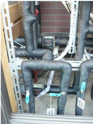
写真4 配管設備に取り付けた電磁流量計
