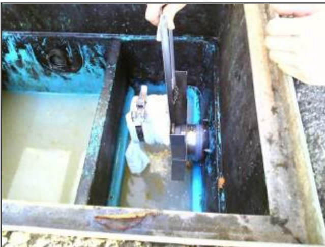
③ 油脂分離槽へネットホルダーをセット
