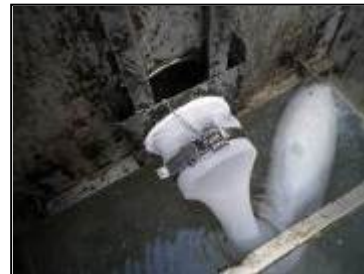
油脂分離槽への装着状況
