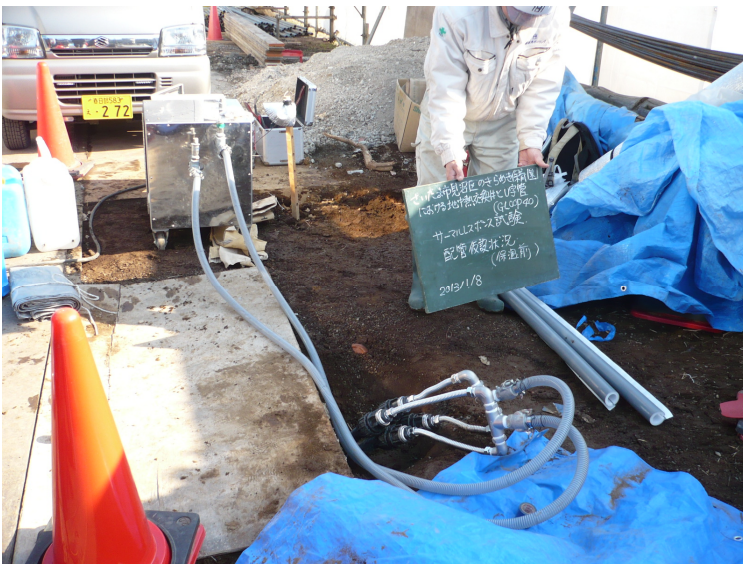
写真2 保温前の配管と装置の接続状況、U字管はダブル
