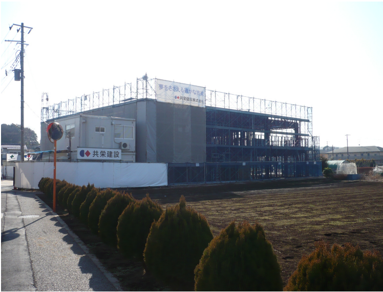
写真1 きらめき保育園工事現場全景
