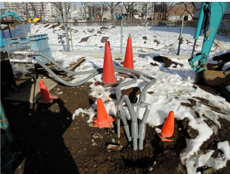
写真4 配管の保温後の接続状況
