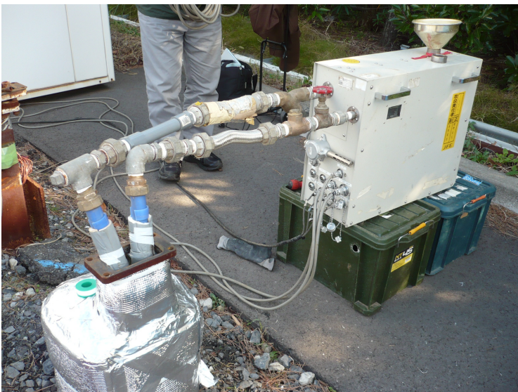
写真3 U字管と試験装置を接続した状況
