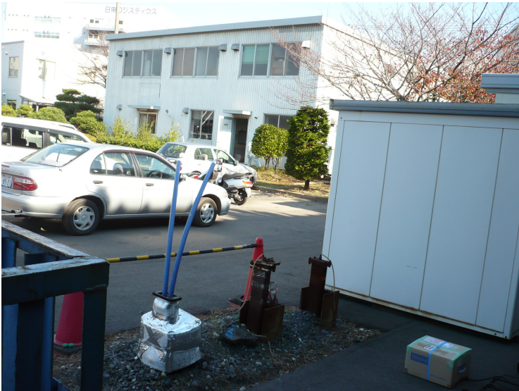
写真2 U字管を挿入し、H形鋼の周りを保温した状況
