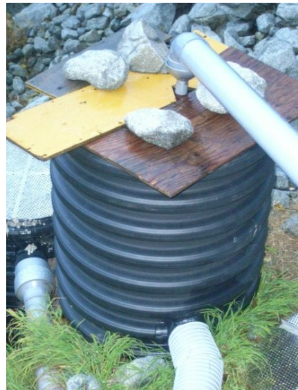
分散装置取り付け後の上部の蓋 (9月28日～)
