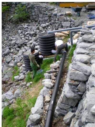
特殊柵の設置状況 3
