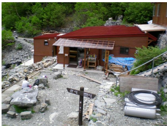
岳沢小屋 外観
