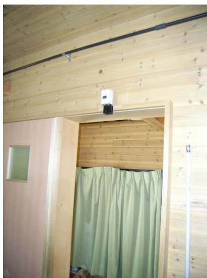
写真 5-4-1-2 利用者カウンターの設置状況
