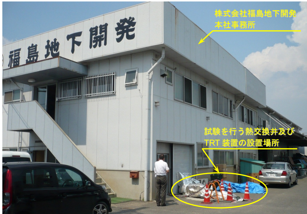
図 3-2 実証試験の実施場所外観写真
